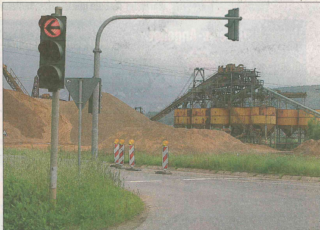
Bis 2010 will die Firma Cemex den bisherigen, auch langsam in die Jahre gekommenen Werksstandort aufgegeben haben. Fotos: Götz Schaub
